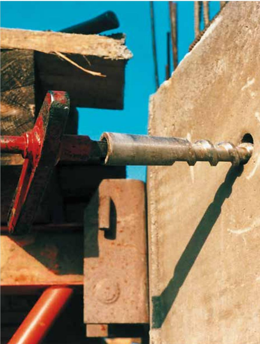
Dès qu'il s'agit de la fixation temporaire d'éléments dans le béton et que leur emplacement est défini à l'avance, les vis récupérables TITAN sont préférables à toutes les pièces perdues (ancres ondulées, épingles à ancrer, douilles filetées, plaques, cônes etc.).
